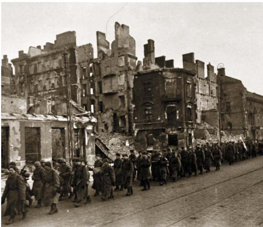
Колонна советских солдат на марше по разрушенной улице Варшавы
